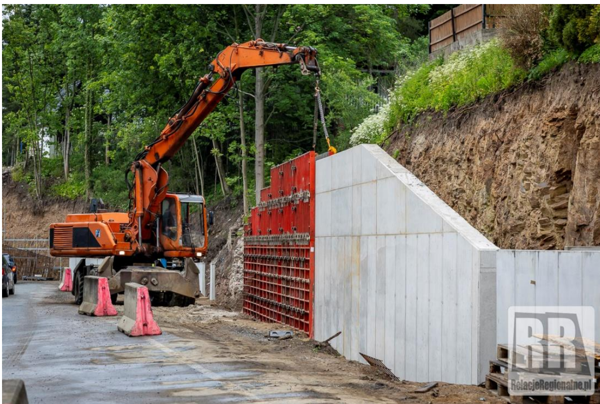
Fot. Remont drogi wojewódzkiej.
