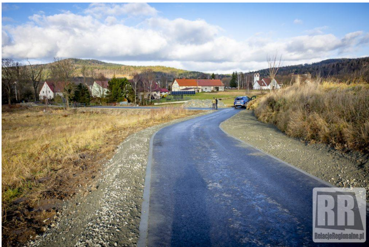
Fot. Remont drogi gminnej 114377 w Sędziszawiu.
