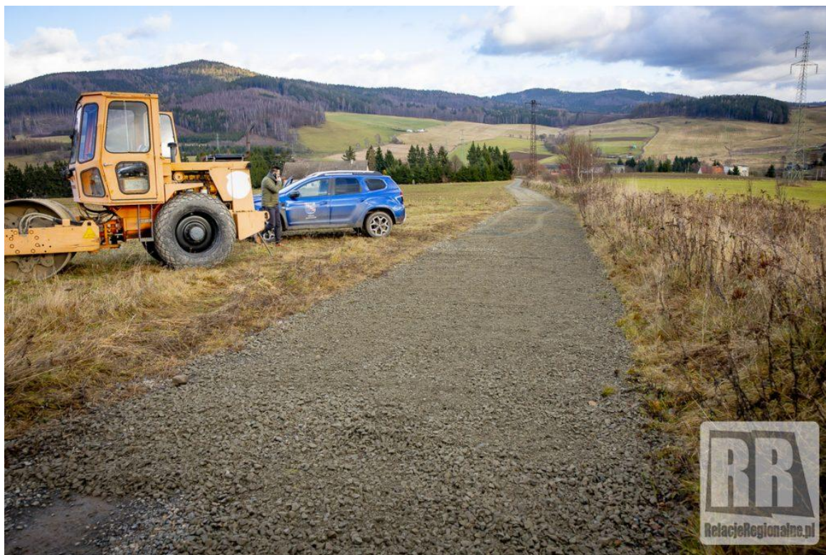
Fot. Remont drogi gminnej 114502 w Marciszowie.
