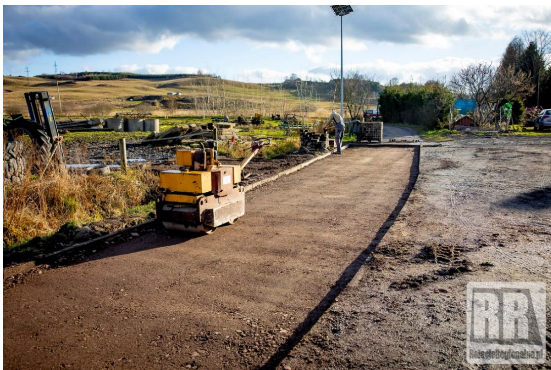
Fot. Remont drogi gminnej 114372 w Marciszowie
