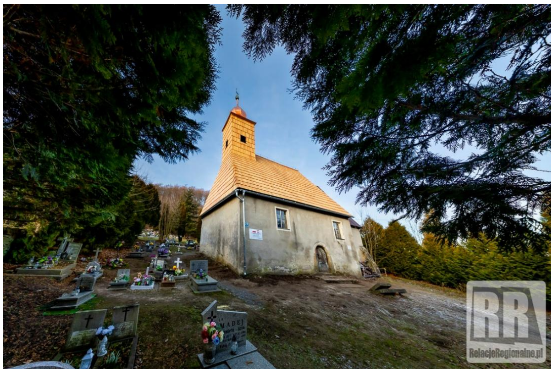
Fot. Remont dachu kaplicy cmentarnej w Wieściszowicach
